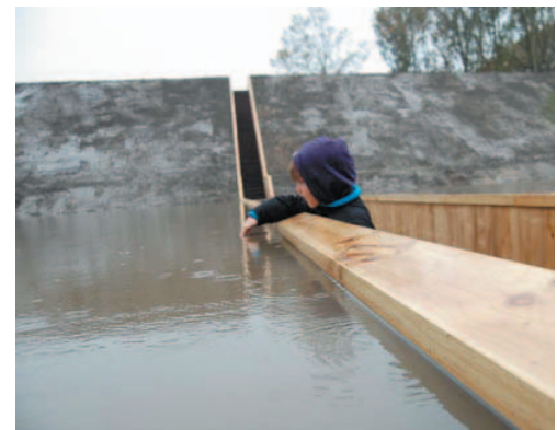
그림 4. 네덜란드의 모세 다리, 물길을 복원하고, 해자를 건너는 수면 아래로 보행다리를 방수목재를 이용해 조성. RO&AD architecten, 네덜란드(나무신문, 2012.10.22)
