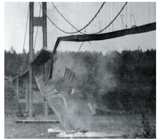
그림 3. 시속 67km의 강풍에 붕괴하는 타코마 해협 대교 (1940,11.7)
