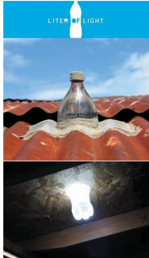
그림 4. 페트병과 물만으로 충분히 빛을 공급하는 적정기술의 훌륭한 사례 “a litter of light” - 기술의 주인은 결국은 사람이다.
